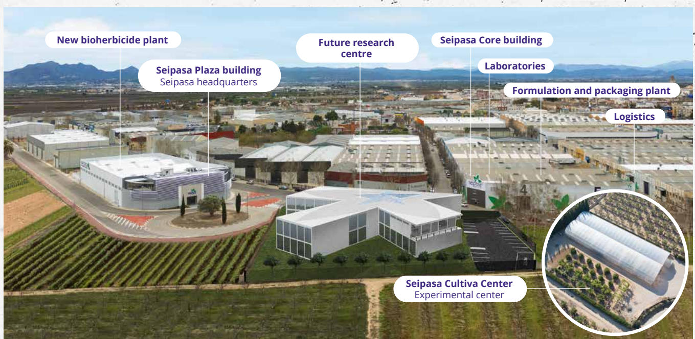
Seipasa industrial complex in l'Alcúdia.
